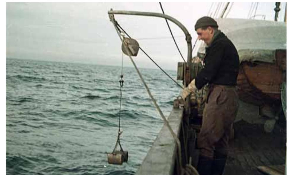
Abb. 3: Arbeit mit dem Petersen-Bodengreifer an der Handwinde auf dem Vermessungsschiff JOH. L. KRÜGER während einer Fahrt im Februar 1952 (Foto: IOW-Bildarchiv).
