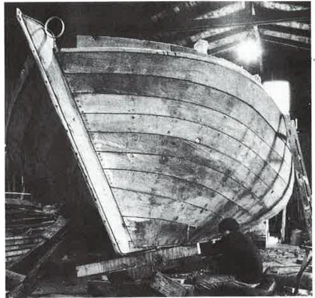
Abb. 17: Das aufgeplankte Boot wird kalfatert
