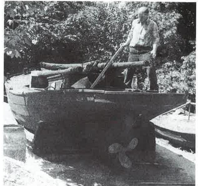
Abb. 3: Das Heck mit Achtersteven und Schiffsschraube
