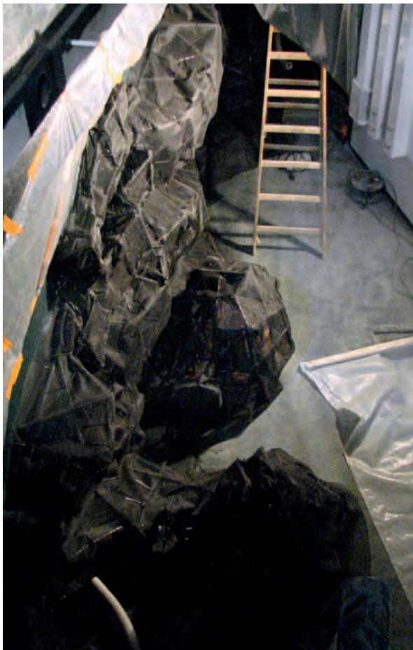
Abb. 5: Verkleidung des Rohrgerüsts mit Trägernetz.
