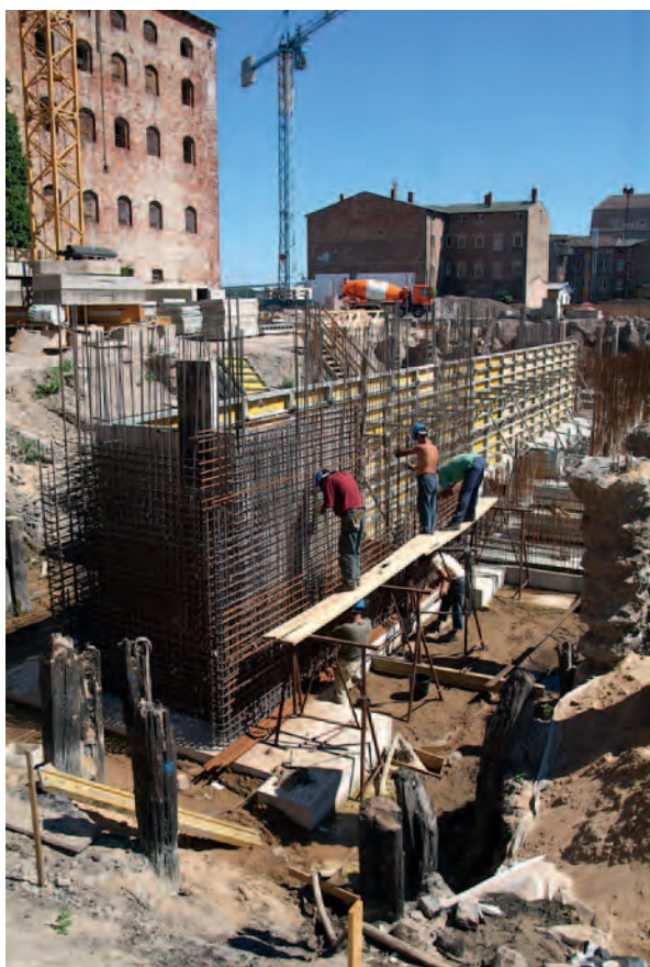
Abb. 4: Die ersten Kellerwände werden geschalt. Teile der Gründung sind bereits fertig gestellt. Im Vordergrund befinden sich noch Reste der mittelalterlichen Hafenanlage.
