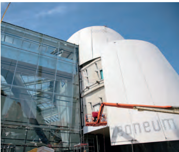
Abb. 27: Die Verglasung des Foyers dauerte bis zum Schluss an. An Schnittstellen mussten sich Gewerke besonders intensiv abstimmen.
