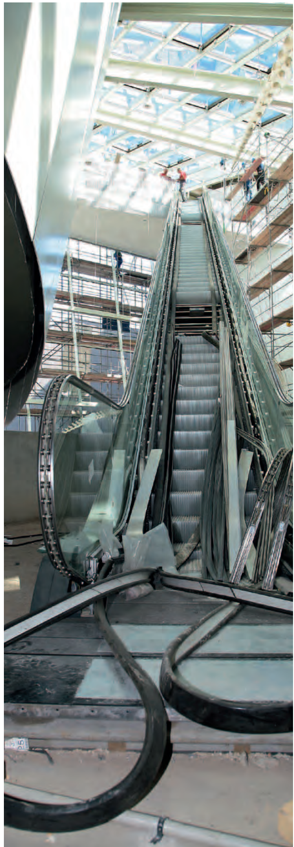
Abb. 28: Das Zusammentreffen aller Ausbaugewerke erforderte ein hohes Maß an Koordination. Bereits während der noch laufenden Bauarbeiten wurden die Ausstellungen, wie hier die Walskelette, installiert.
