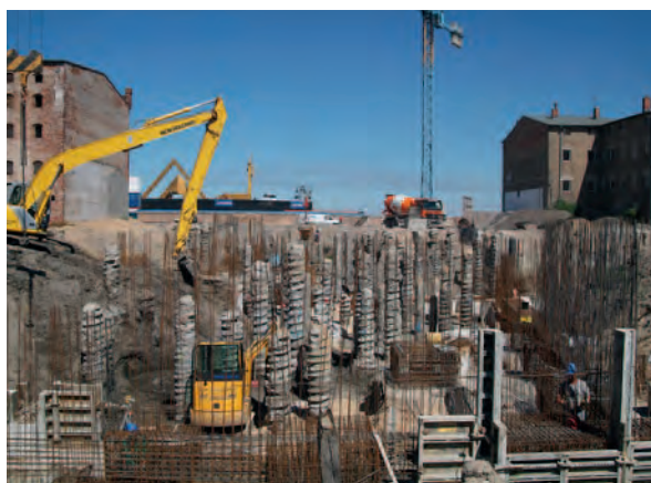
Abb. 3: Zur Herstellung der Gründung blieb in der Baugrube wenig Raum. Die Bohrpfähle wurden bis auf die jeweils erforderliche Höhe abgestemmt und mit einem stahlbewehrten Zerrbalkensystem verbunden.
