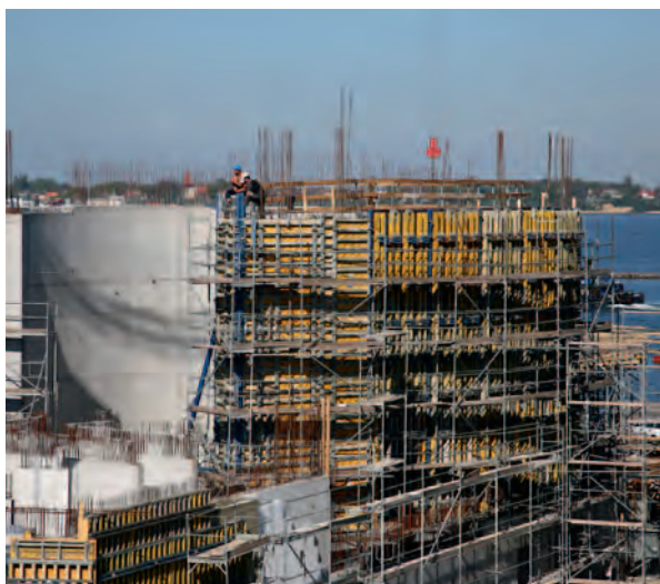
Abb. 12: Der Bau des großen Schwarmfischbeckens erfolgte in Abschnitten. Die Öffnungen für die Scheiben müssen exakt geschalt und betoniert werden.
