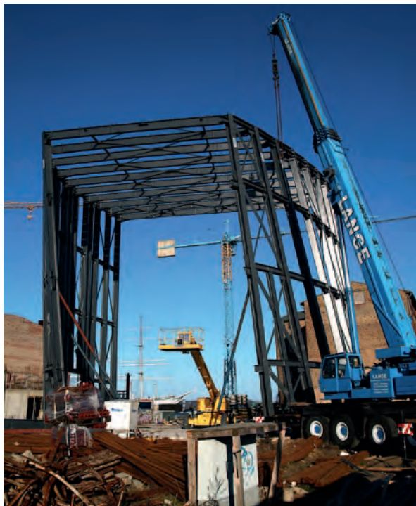
Abb. 9: Der Stahlbau für das Bauteil „Riesen der Meere“ geht zügig und professionell vonstatten. Berge von Bewehrungsstahl und anderem Material liegen auf der Baustelle.
