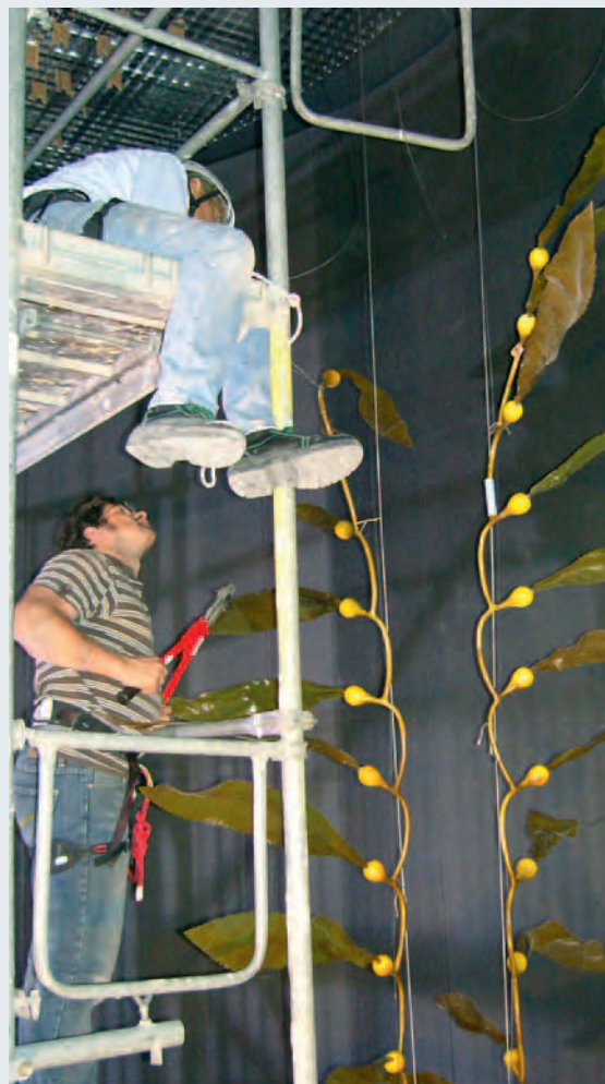
Abb. 3: Montage der vormontierten Riesenkelpsegmente vom Gerüst aus.
