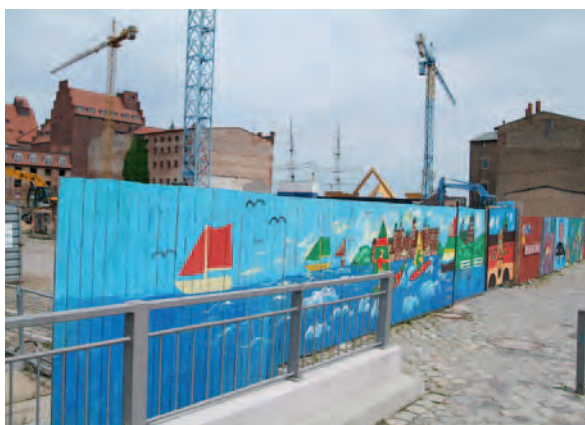
Abb. 2: An dem Malwettbewerb beteiligten sich Künstler und Schüler aus der Region. Innerhalb des Bauzaunes begannen die Bagger tiefe Löcher für die Baugruben auszuheben. Die zuvor betonierten Pfähle mussten bis auf Höhe der Kellersohle wieder abgestemmt werden. Bei dem wunderschönen Wetter war das durchaus eine schweißtreibende Angelegenheit.
