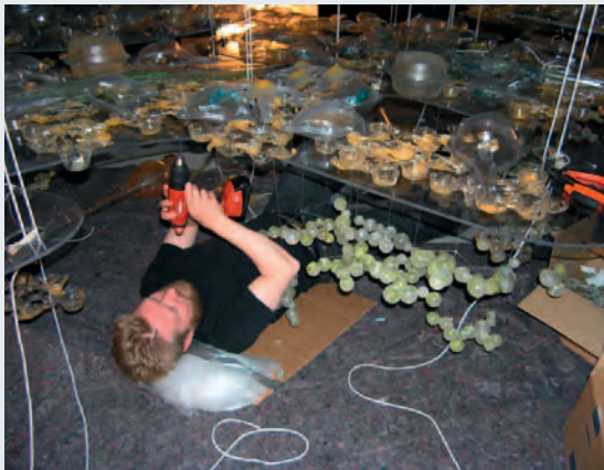
Abb. 10: Die Firma 10 Tons bei der Montage.
