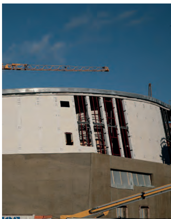
Abb. 20: Vor Einbruch des Winters musste der Bau dicht sein. Die Außenwände wurden überwiegend als Trockenbaukonstruktion hergestellt.
