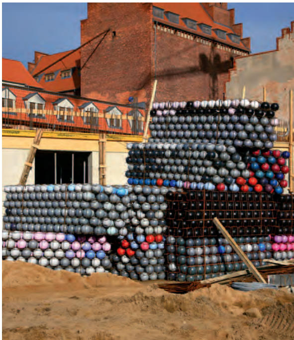
Abb. 7: Mit Cobiaxkugeln wurden die Betondecken gefüllt, um Eigenlasten zu reduzieren.
