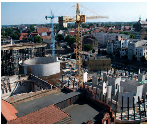
Abb. 14: Unmittelbar nach den Rohbauarbeiten wurden die Betonbecken abgedichtet. Außenwände und Becken der Aquariengeschosse konnten erst nach der Scheibenmontage errichtet werden.
