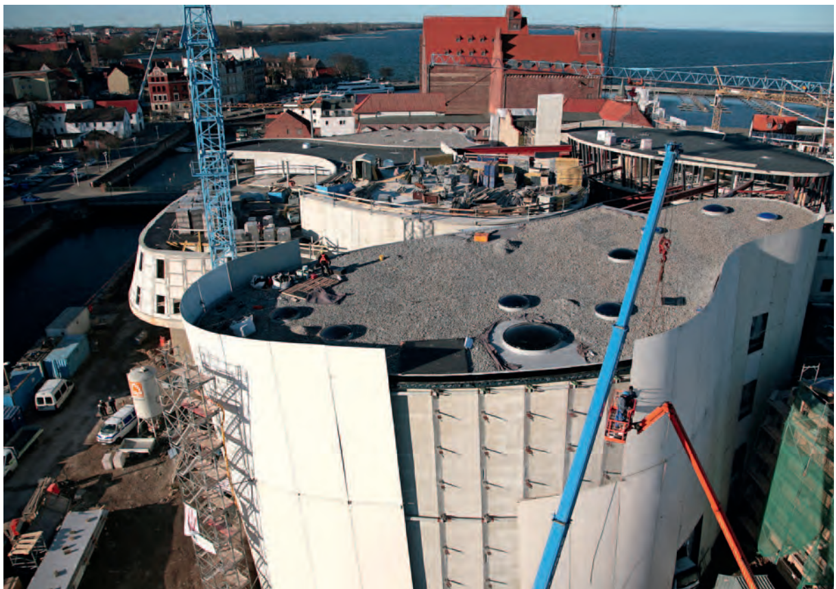
Abb. 25: Die Dächer wurden bis auf die begehbaren Terrassen mit Feuersteinkieseln abgedeckt.
