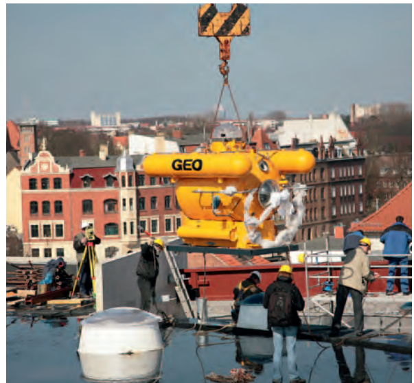
Abb. 24: So lange große Öffnungen in den Decken und Dächern vorhanden waren, konnten schwere Bauteile, aber auch Exponate per Kran in die Gebäude geschafft werden.
