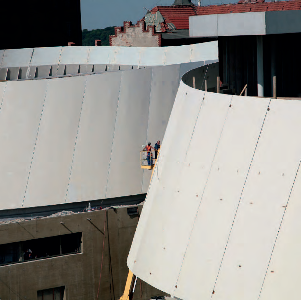
Abb. 26: Die Endbeschichtung der Stahlfassadenplatten wurde nach Abschluss aller Schweißarbeiten vor Ort aufgetragen.
