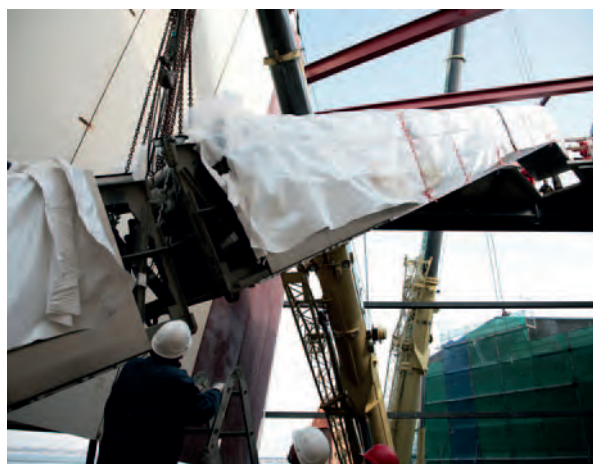
Abb. 23: Unter und zwischen den Dachträgern des Foyers war nicht viel Raum, um die mehr als 30 Meter lange Fahrtreppe an Ort und Stelle zu zirkeln.
