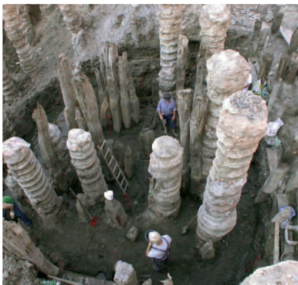
Abb. 15: Juni 2006: Hansestadt Stralsund, OZEANEUM, Semlower Brücke. Schnitt 3 Grabungsarbeiten zwischen Beton-Bohrpfählen und Eichenpfosten.
