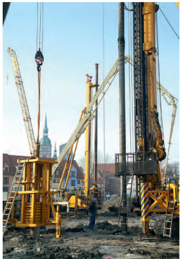
Abb. 1: Mit Großbohrgeräten wurden 691 Gründungspfähle hergestellt.
