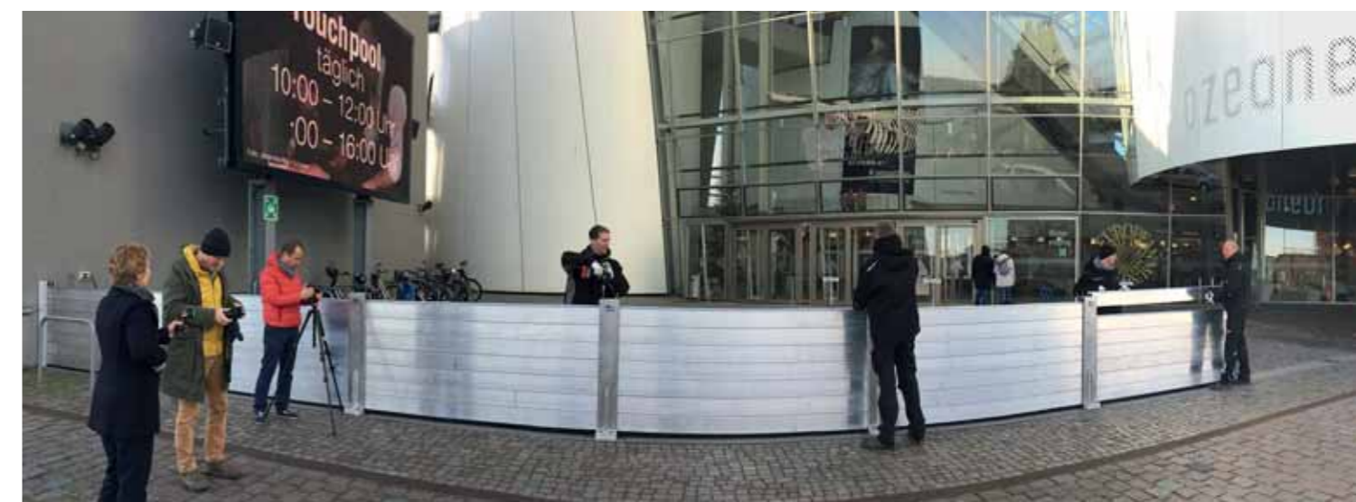
Für Dreharbeiten wird regelmäßig viel Aufwand betrieben. Hier baute das Technik-Team ein Stück der Hochwasserschutzwand dafür auf.
